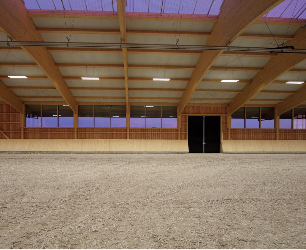
**Abb.:** Die zu beleuchtende Fläche der Reithalle misst 22m x 54m. Die mittlere Beleuchtungsstärke auf dem Boden beträgt  $E_m=350\text{lx}$  bei einer Gleichmäßigkeit von  $g_1=0,725$ . Die Leuchten wurden in einer Höhe von 7,15m montiert.
